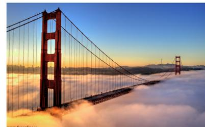
Man betrachte nun also Seile unter **konstanter Linienlast**, d.h. das Eigengewicht des Seils kann vernachlässigt werden (bei hinreichend schweren Konstruktionen). Sei  $q$  die Masse der Brücke pro Meter, so folgt:
